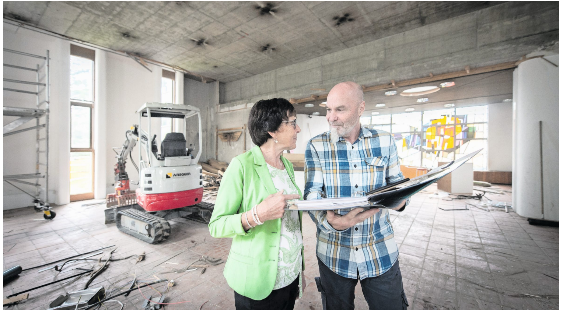
Die Kapelle des «Blickfelds» wird bald rückgebaut: Doris Amrhein, Vorsitzende der Geschäftsleitung, und Bauleiter Martin Ulrich.
