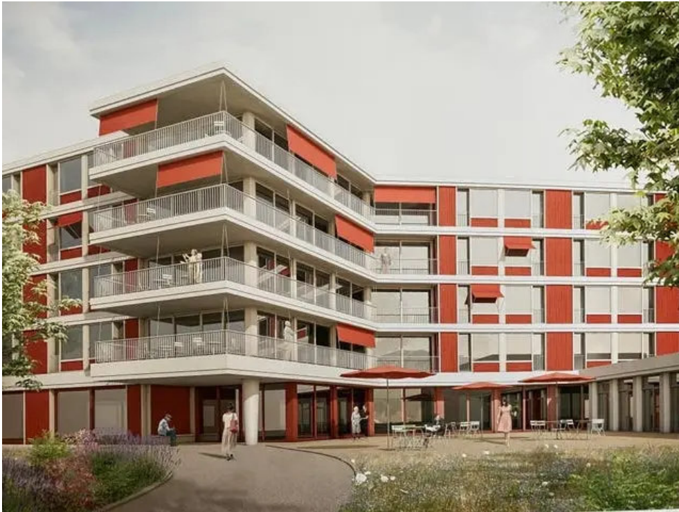
Ansicht des künftigen Pflgetrakts von der Brändistrasse her. Visualisierung: PD/BVFI
